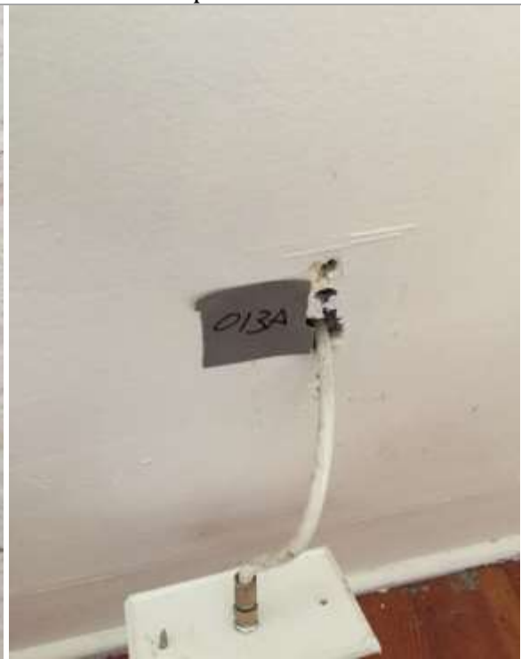
013A-Plaster Living Room
