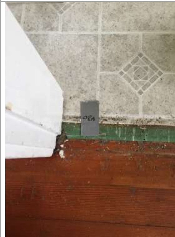
08A-Top layer Flooring Hallway
